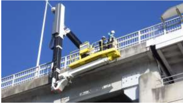
橋梁点検車乗車体験
