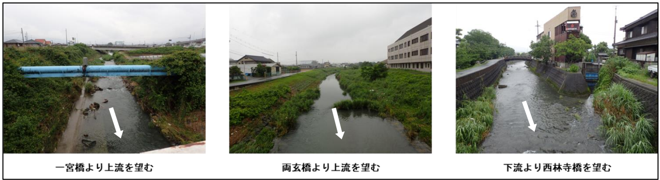
河川状況（内川）
