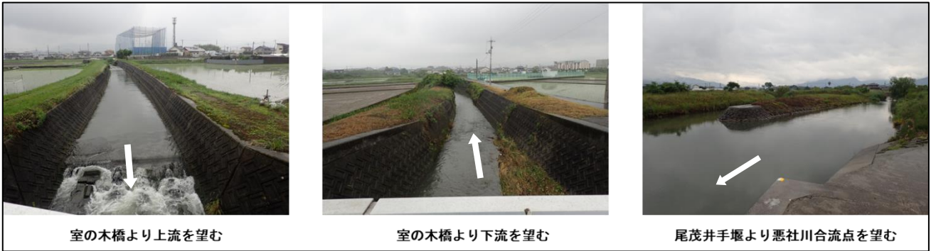
河川状況（悪社川）
