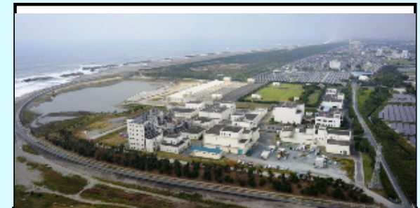
西遠浄化センター（提供：旧静岡県下水道公社）
