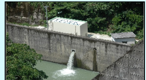
全国初の導入スキームで建設した町営二川小水力発電所
