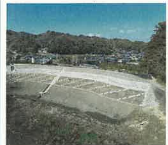
ため池の改修 （山之内地区山田池）
