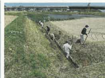
共同活動 （水路の泥上げ）
