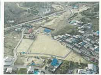
再編復旧 （上浦地区井口工区）
