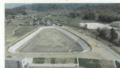
正尺池（河野地区）の改修状況
