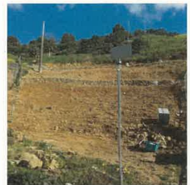
農家自主施工による緩傾斜化
