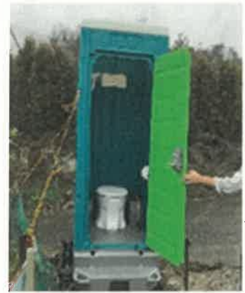
仮設トイレの整備
