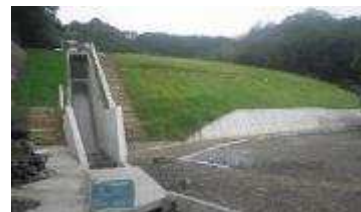
ため池の改修整備
