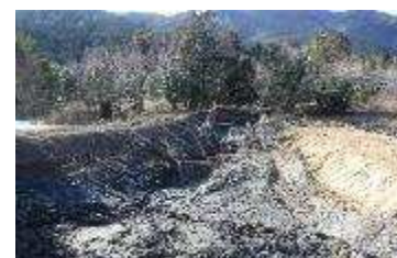
ため池改修工事中
