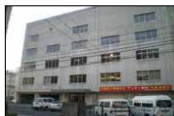
第二庁舎(耐震改修)
