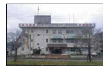
内子交番(耐震改修)
