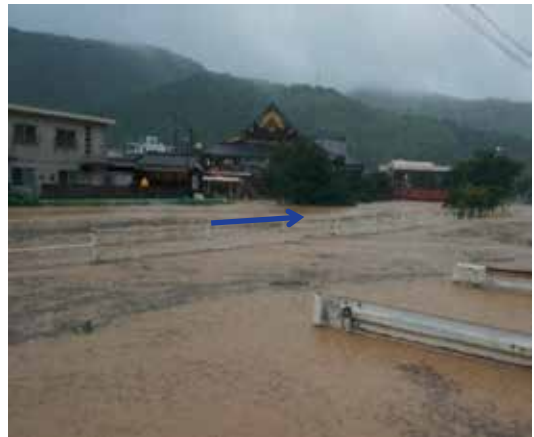
(二) 立間川水系河内川 (宇和島市) 平成 30 年 7 月 西日本豪雨
