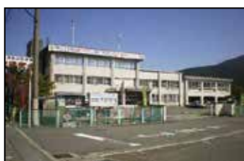
久万高原警察署(耐震改修)
