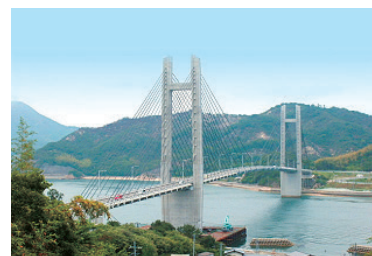
上島架橋（生名橋）
