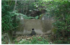
【コンクリートの谷止め】
