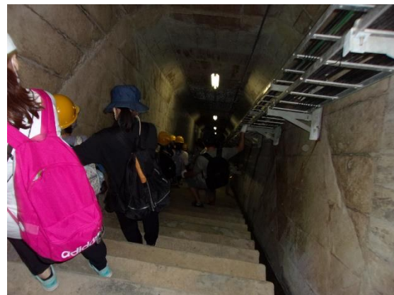
ダムの中（監査廊）を移動中
