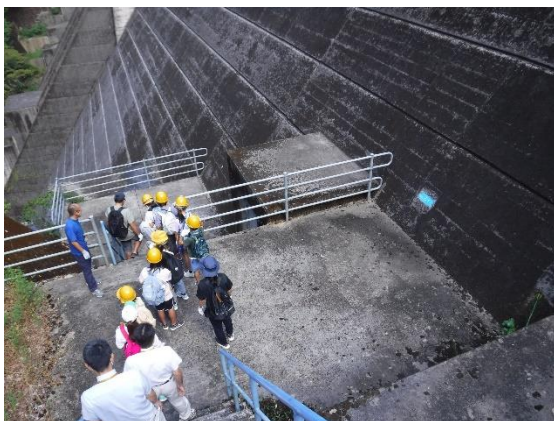
監査廊に移動中
