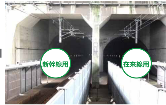
鷲羽山トンネル
