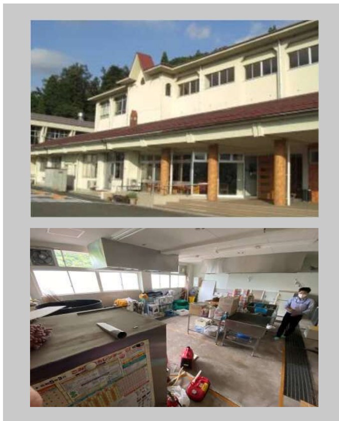
旧小学校をドローンデポ ® に改修
