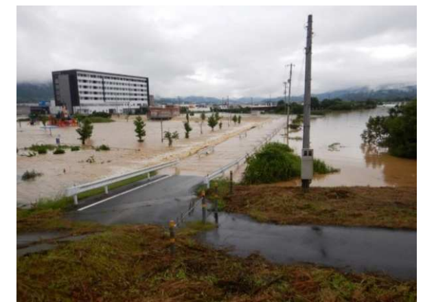
平成30年7月（梅雨前線） 二線堤越流状況
