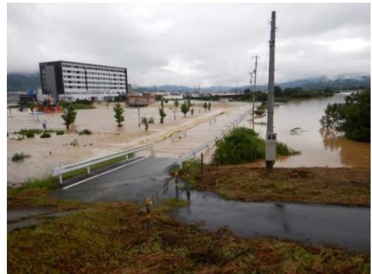
平成 30 年 7 月 (梅雨前線) 二線堤越流状況
