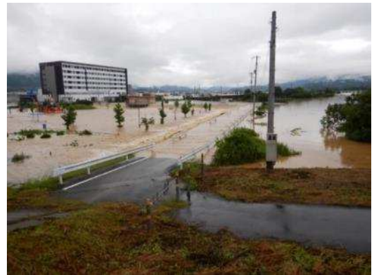
平成 30 年 7 月 (梅雨前線) 二線堤越流状況
