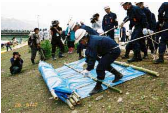
シート張り工
