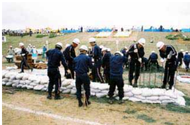
積み土のう工
