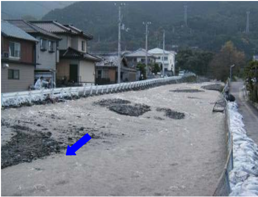
四国中央市 (二)西谷川 河道埋塞
