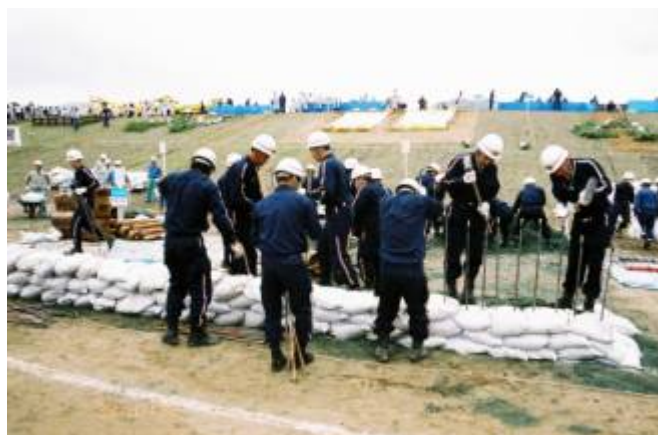
積み土のう工
