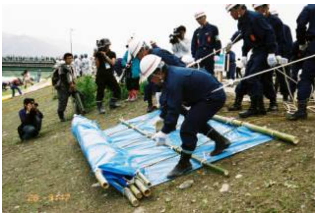
シート張り工
