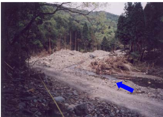
被災状況 護岸が流出し河道が埋塞
