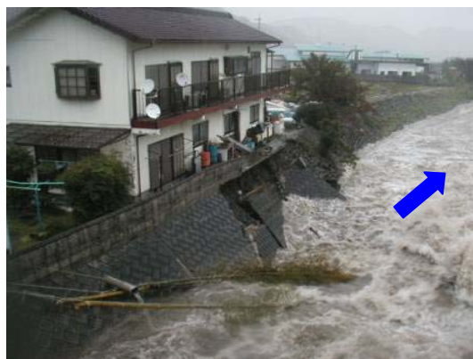
四国中央市 (二)関川 護岸崩壊
