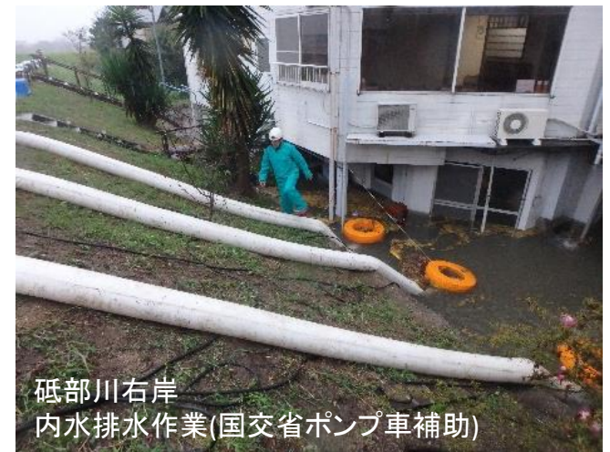
砥部川右岸 内水排水作業(国交省ポンプ車補助)
