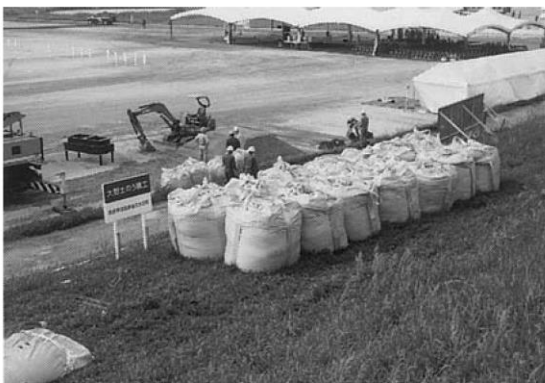
(大型土のう工)
