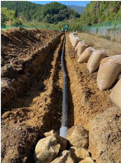
【もみ殻の投入と排水パイプの設置】
