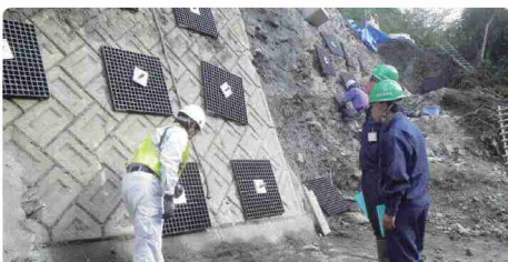
建設現場の見学を実施しました。
