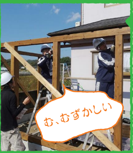
柱を固定するために、ネジ(ビス)を打ち込みます。
