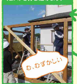
柱を固定するために、ネジ(ビス)を打ち込みます。
