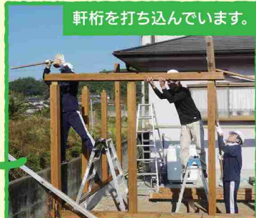
柱を固定するために、ネジ(ビス)を打ち込みます。
