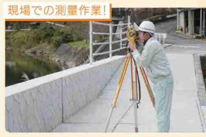
現場での測量作業!
