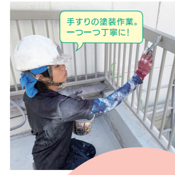
建物の外壁を塗装中。誠心誠意、真心を込めて
