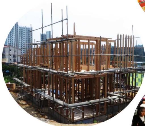
県産材住宅の建築 (韓国)
