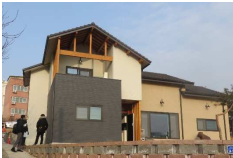
県産材住宅の建築 (韓国)
