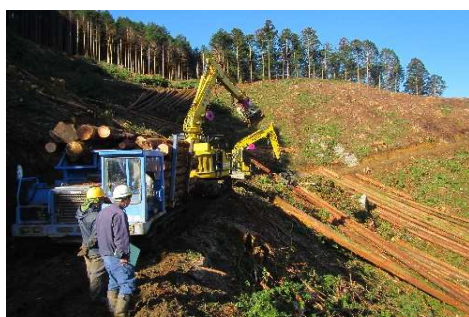
主伐による素材生産
