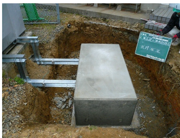
図 4. 整備した基礎との緊結(伊方越局)
