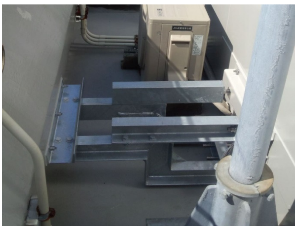
図 3. 局舎と基礎建物との緊結(湊浦局)
