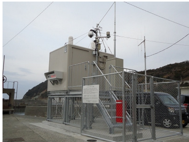
図 2. 嵩上げ後のモニタリングポスト (大成局)
