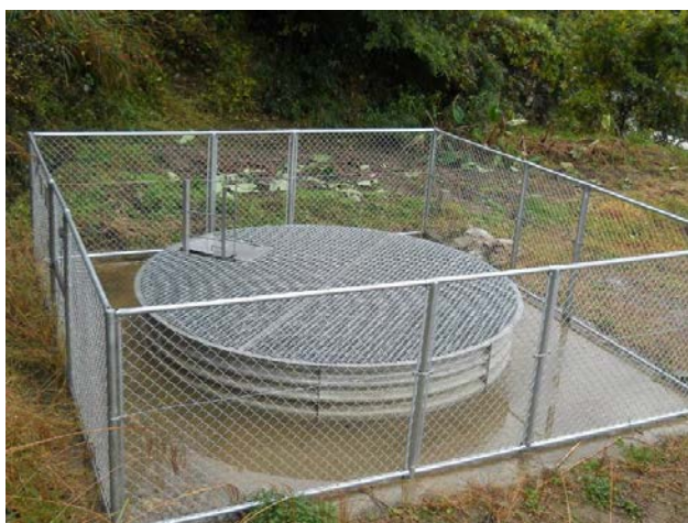
富岡工区Bブロック 1号集水井施工状況
