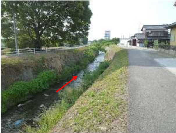
写真 4-5 未整備状況 (SP. 3100)
