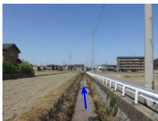
写真 2-8 SP1740 付近の現況写真
