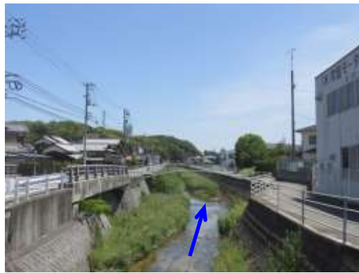
写真 2-2 SP 2800 付近の現況写真
