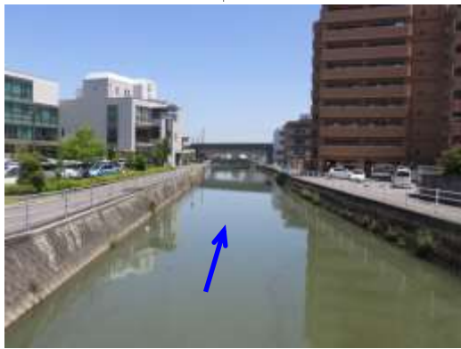
写真 2-1 SP 1300 付近の現況写真
