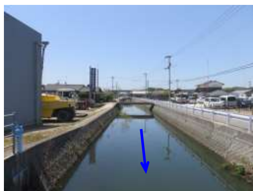
写真4-5 整備状況（山田川SP120付近）
