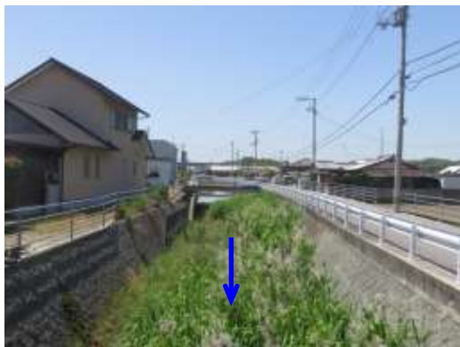
写真 2 - 5 SP 60 付近の現況写真
