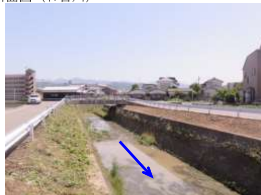
写真 2-4 SP 620 付近の現況写真
