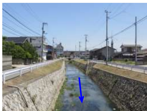
写真4-3 整備状況（日吉川SP50付近）
