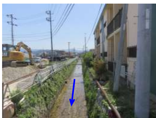
写真 2-7 SP1080 付近の現況写真
