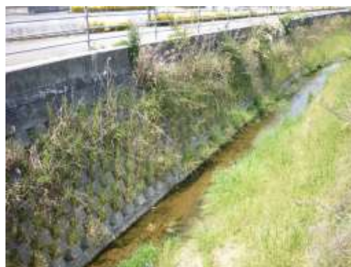
写真 7-2 環境保全型ブロック護岸
