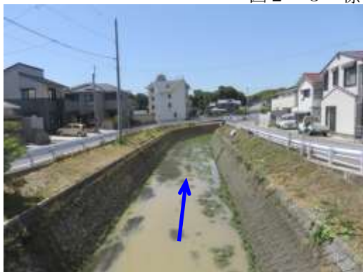
写真 2-3 SP 400 付近の現況写真
