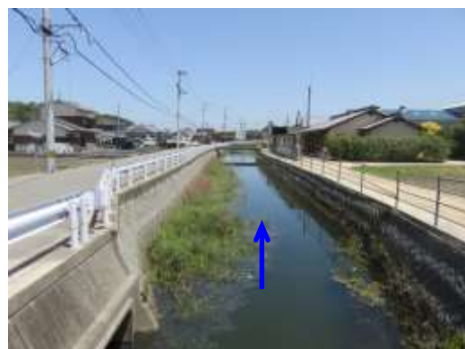
写真 2 - 6 SP 210 付近の現況写真
