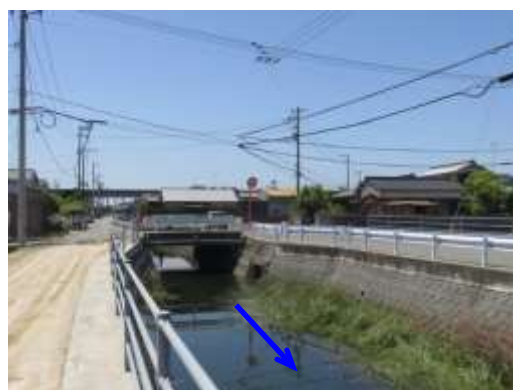
写真4-6 整備状況（山田川SP220付近）
