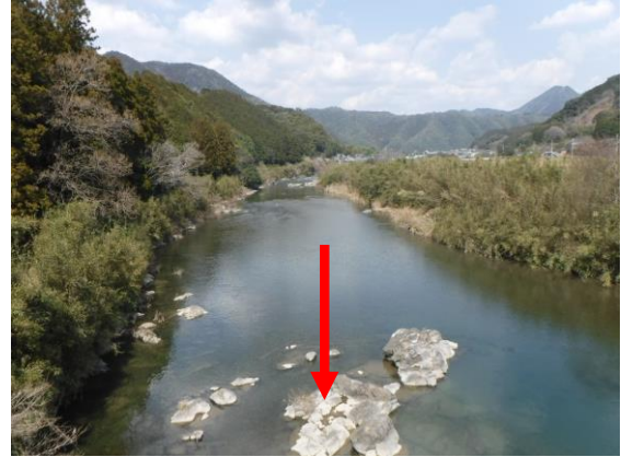
写真 4-8 未整備状況 (SP. 12605)
