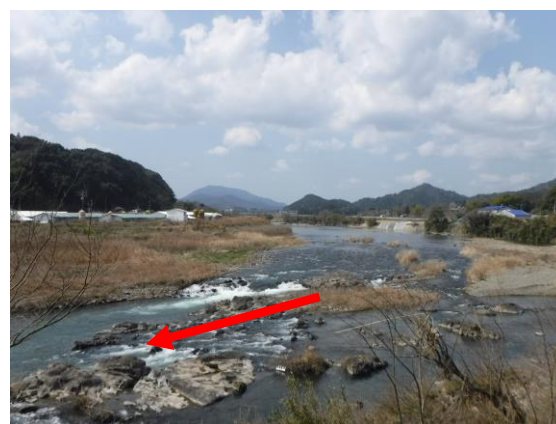
写真 4-6 未整備状況 (SP. 10700)
