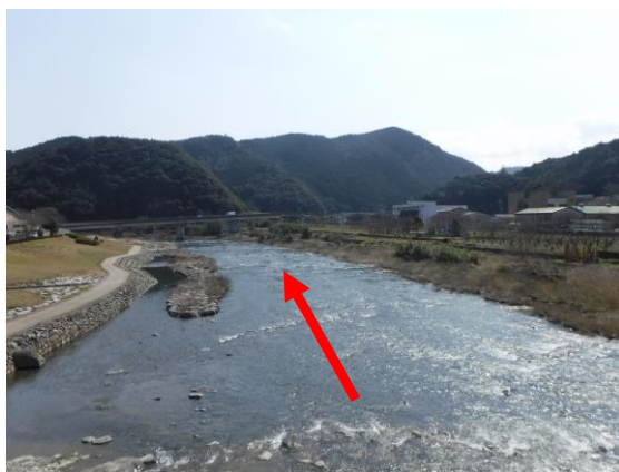
写真 4-4 左岸整備状況 (SP. 7700)
