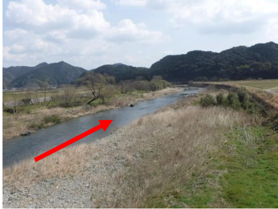
写真 4-7 未整備状況 (SP. 11900)
