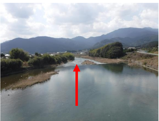
写真 4-5 未整備状況 (SP. 9030)
