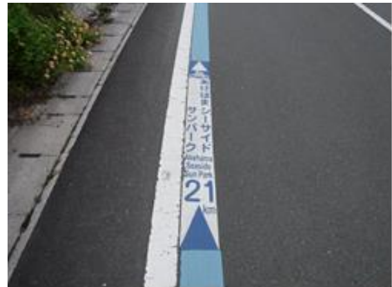
国道 378 号蔵貫地域に明示されている 自転車用案内表示
