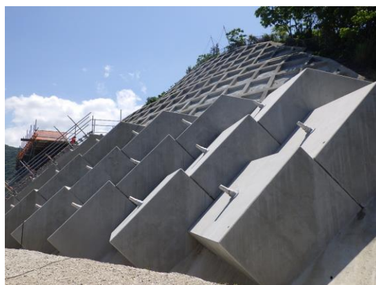
アンカー工施工中
