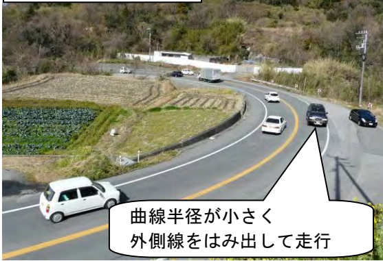
急カーブの走行状況
