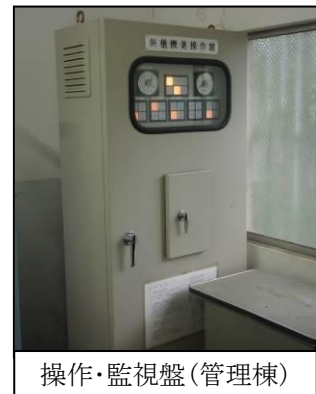
ゲート開閉装置(管理棟)
