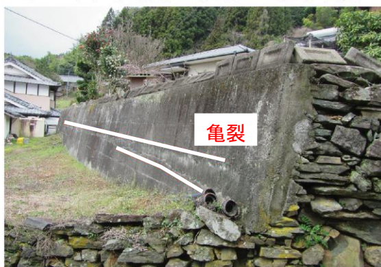
ブロック末端部の擁壁への水平亀裂
