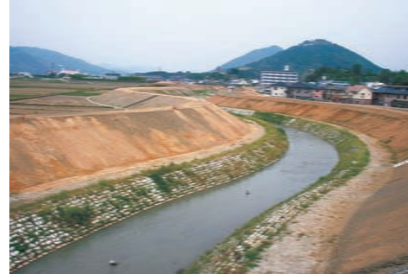
一級河川肱川水系久米川(大洲市)
