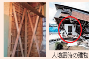
耐震改修(筋かい追加)
