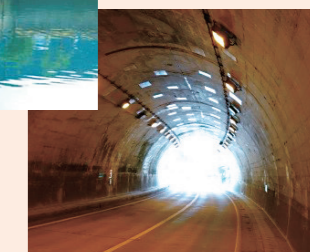
トンネル壁面の補修
