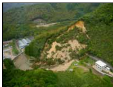
防災ヘリによる被災状況確認
