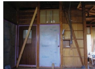
(筋かい工事中)
