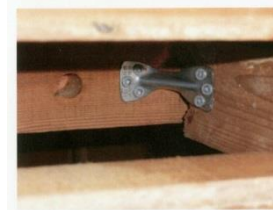
柱頭金物による補強
