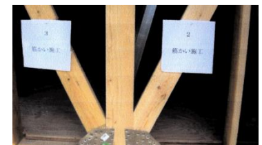
壁筋かい・金物施工
