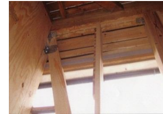
(筋かい金物による補強)
