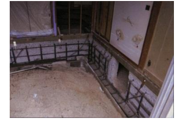
(台所基礎配筋)
