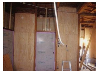
(構造用合板施工後)
