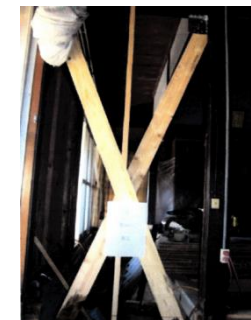
壁筋かい・金物施工
