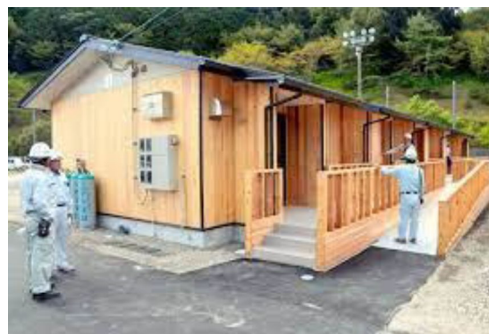
平成30年豪雨災害において整備された県産材を活用した応急仮設住宅
