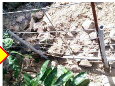
イノシシの侵入穴（修繕後）
