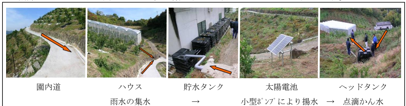
図：太陽エネルギーを利用した自動点滴かん水施設
