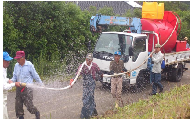
センチピードグラスの吹付け作業
