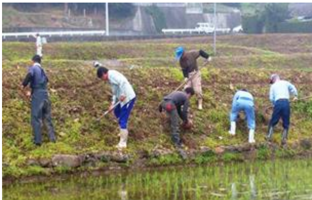
吹付け作業の前の苔除去作業
