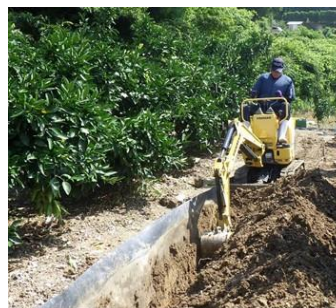
シールディングシートの埋設作業
