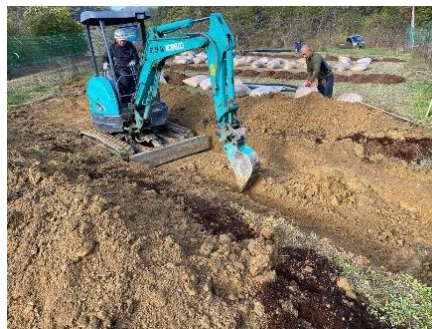
バックホウによる作業
