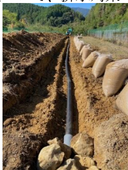
もみがらの投入と排水パイプの設置
