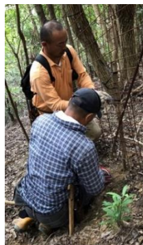
防護柵の補修
