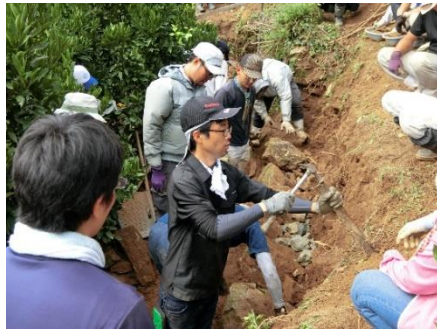
石垣の修復状況
