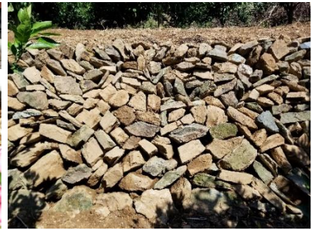
積みあがった石垣
