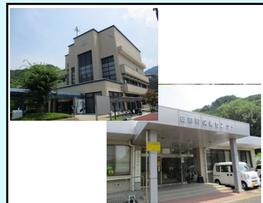
砥部庁舎及び保健センター
